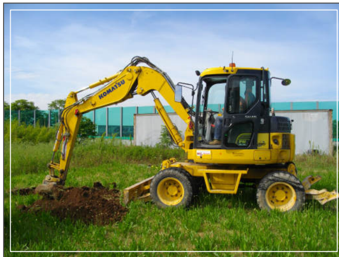
POSTAZIONE DELLA PROVA PP2
