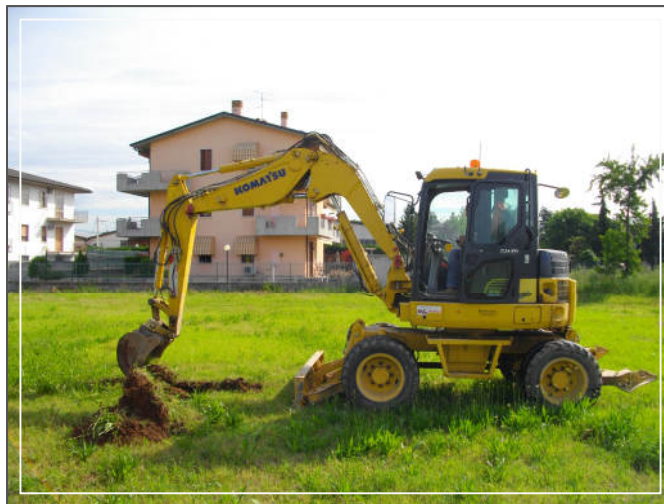
POSTAZIONE DELLA PROVA PP1
